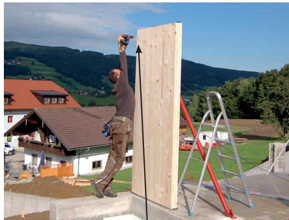
Montaža kutnog spoja
